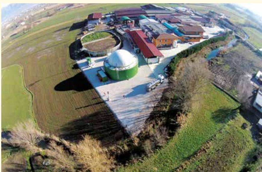
**Figura 2 - Foto aerea del caseificio. Ben visibile nel retro il biodigestore anaerobico da 40 tonnellate ed il motore da 100 kWp.**
