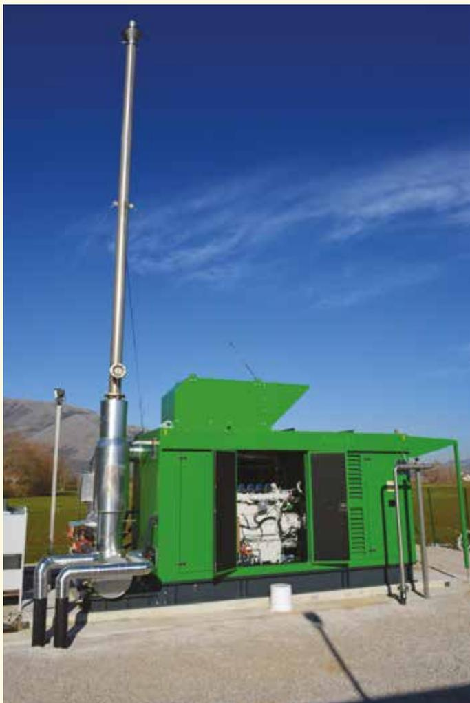
**Figura 3 - Il motore a biogas da 100 kWp.**
